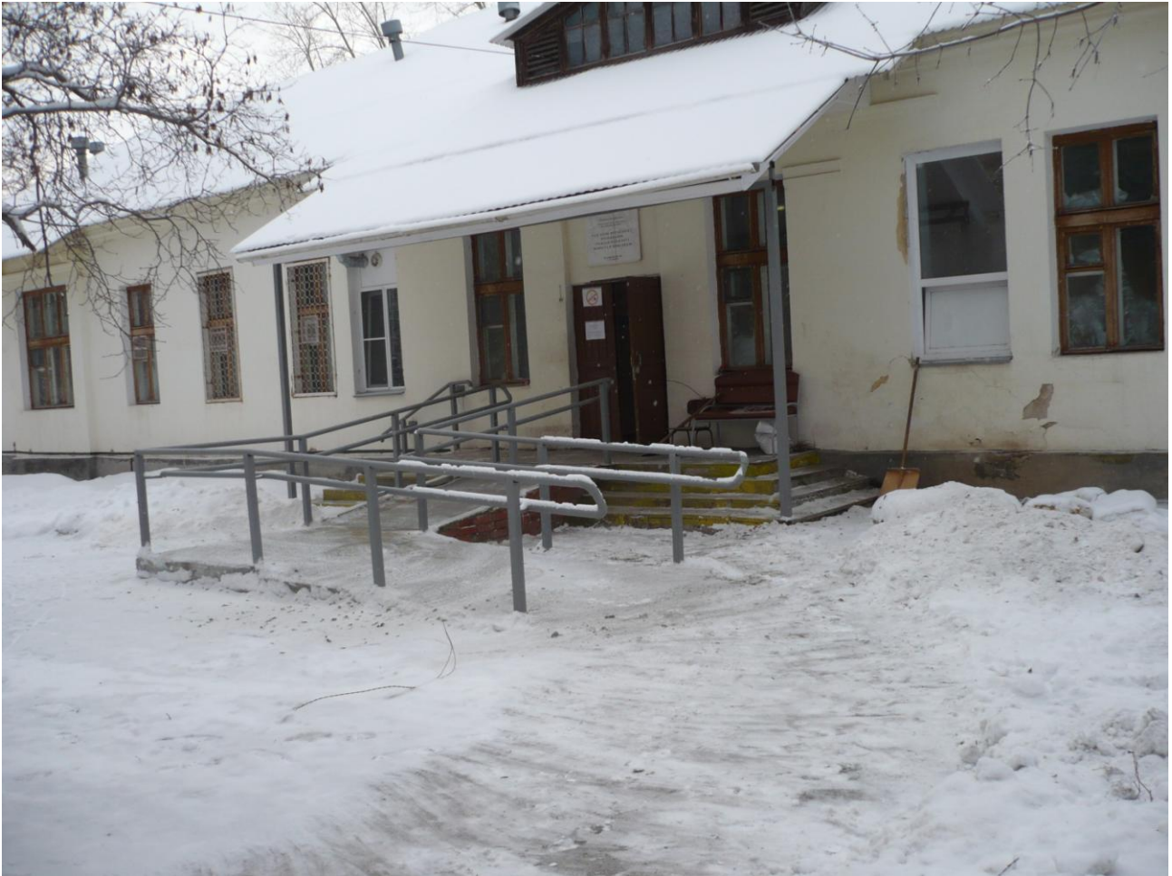
Входная группа после проведения ремонта
